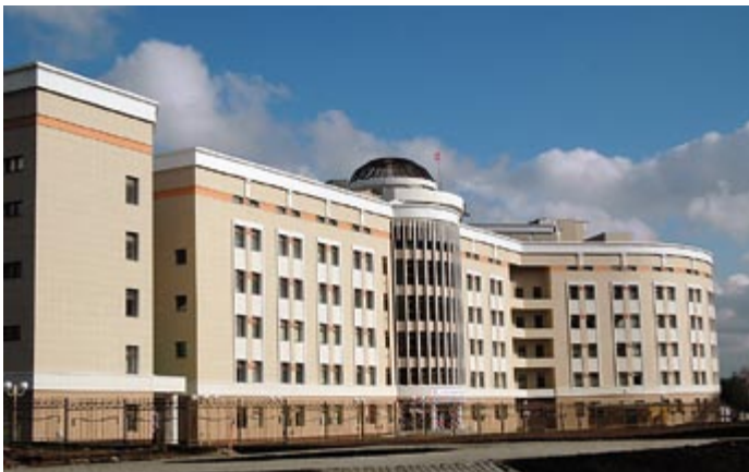
Здание медицинского центра МГУ, Москва
